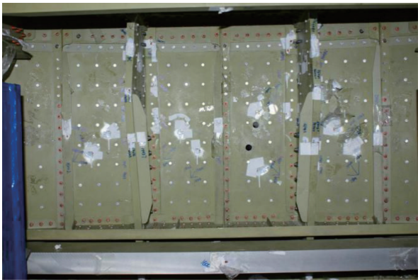
图 7 龙骨梁后延伸段失稳破坏照片
